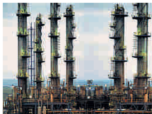
Torres de destilação em uma refinaria de petróleo.
