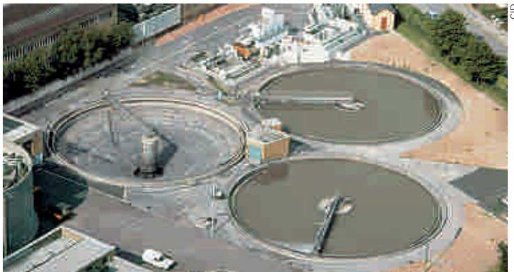
Vista aérea de uma estação de tratamento de água.
