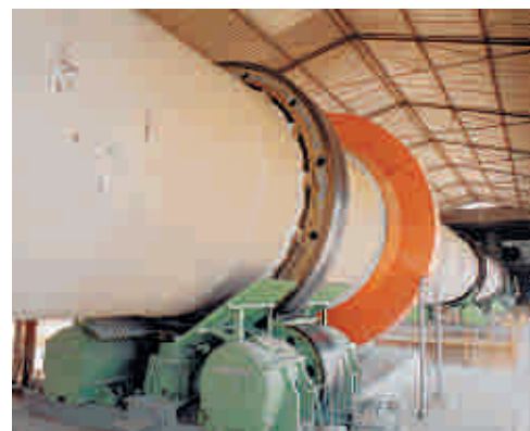
Forno rotatório de uma fábrica de cimento em Mossoró, RN.
