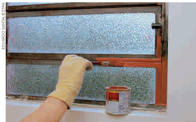
Pintor utilizando zarcão (óxido vermelho de chumbo), usado como pigmento na confecção de tintas de proteção.
