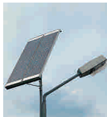
Painel de energia solar em poste de iluminação.
