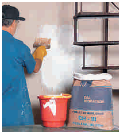
O óxido de cálcio ( \text{CaO} ) é chamado de cal virgem ; com a água, forma a chamada cal hidratada — \text{Ca}(\text{OH})_2 —, que é usada para pintar paredes, troncos de árvores etc. (pintura de caiação).
